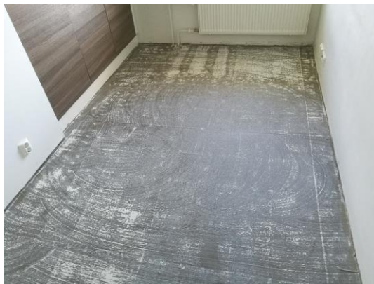
Matto poistettu, liiman & tasoitteen hionta kesken
