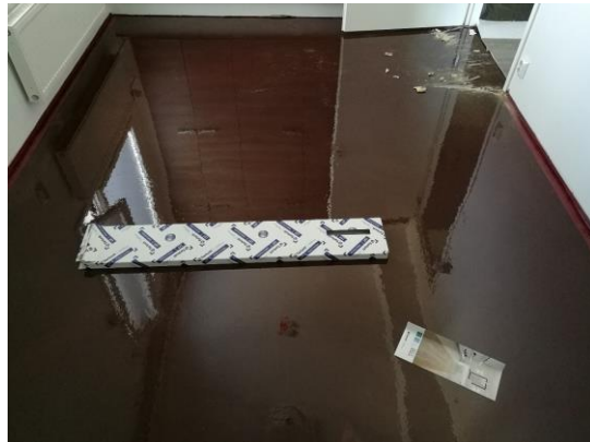
kapselointiepoksi asennettu
