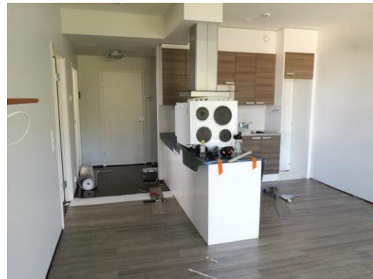
uusi lattiapäällyste laminaattia
