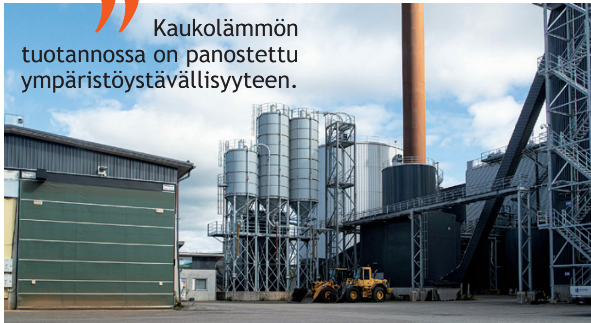
Valmiin tuhkarakeen varastohalli ja taustalla tuhkarakeistamon tuhkasiilot Suosiolan voimalaitoksella Rovaniemellä.
